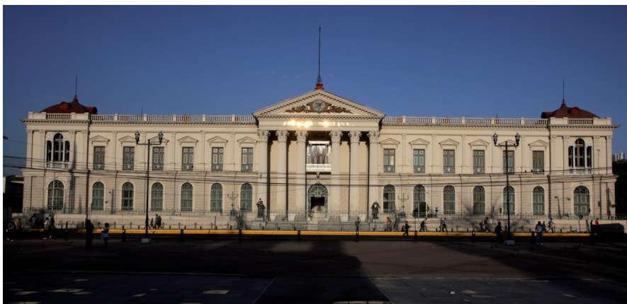
Fachada principal del Palacio Nacional, San Salvador (Alcaine, González, Peralta, 1911) Fotografía de Oscar Leiva (2012), propiedad de Fundación AccesArte
